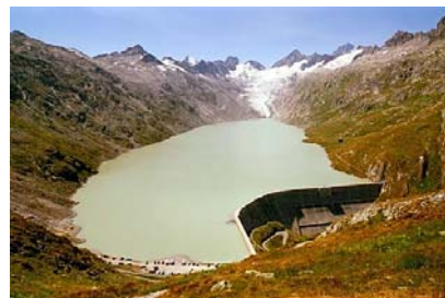
Figure 6 - Le barrage de Oberaarsee, BE
