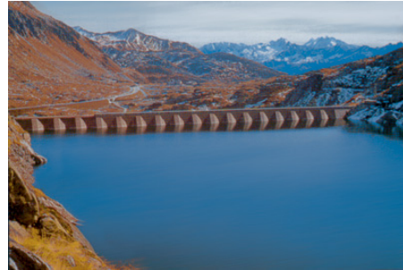
Figure 8 - Le barrage de Lucendo, TI
