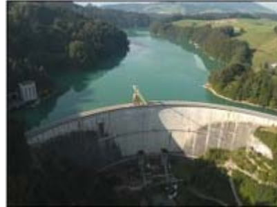
Figure 4 - Barrage de Rossens, FR
