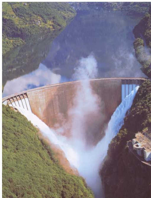
Figure 19 - Evacuateur de crue
