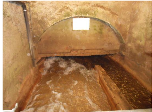
Figure 25 : Indice sur le poste n°3
