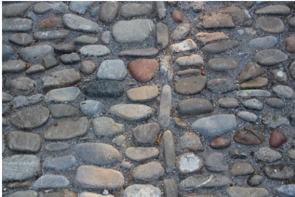
Figure 24 : Indice sur le poste n°2
